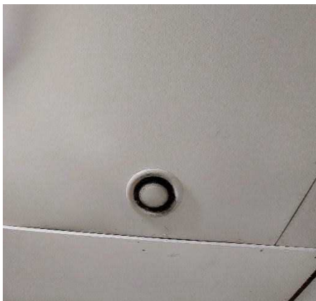
Likainen poistoilmaventtiili.
