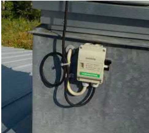
IV-koneen läpivienti vesikatolla
