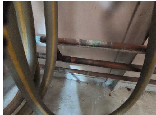
Käyttövesijohdoissa korroosiota.
