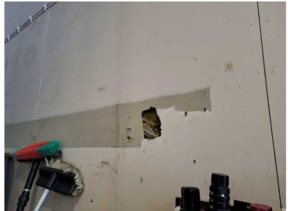
Väliseinälevyissä reikä
