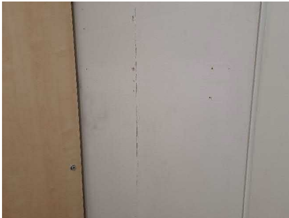
Levyseinärakenteessa halkeama
