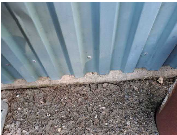
Profiilipelti laskeutuu sokkelirakenteiden päälle
