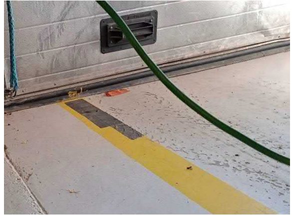
Pinnoitevaurioita uusituslaattarakenteessa
