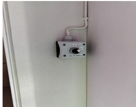
Poistoilmahuippuimurin ohjauskytkin.
