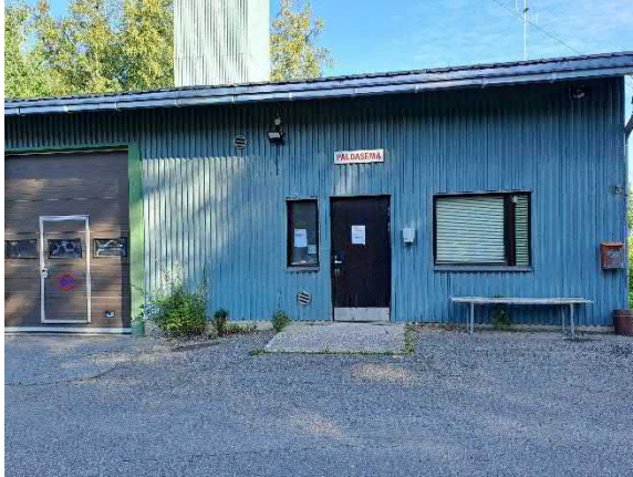
Ulko-oven edustan betoniluiska ja penkki
