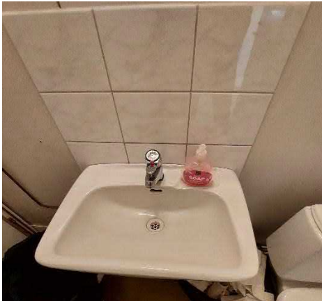
Alkuperäinen pesuallas ja pesuallashana.
