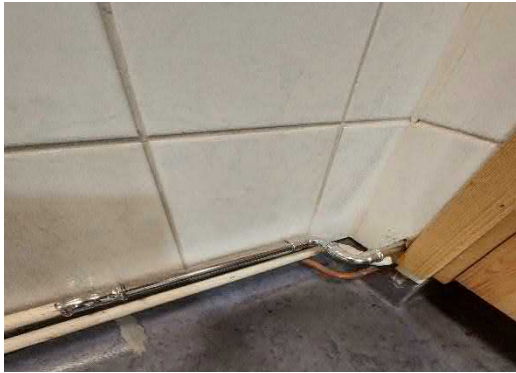
Kylpyhuonetiloissa korjattuja putkiosuuksia.
