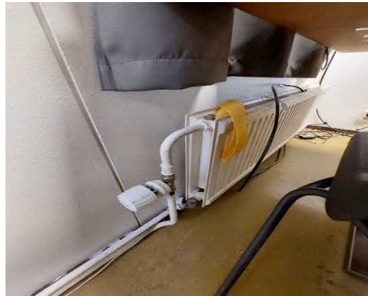
Uusittu patteriventtiili ja termostaatti.
